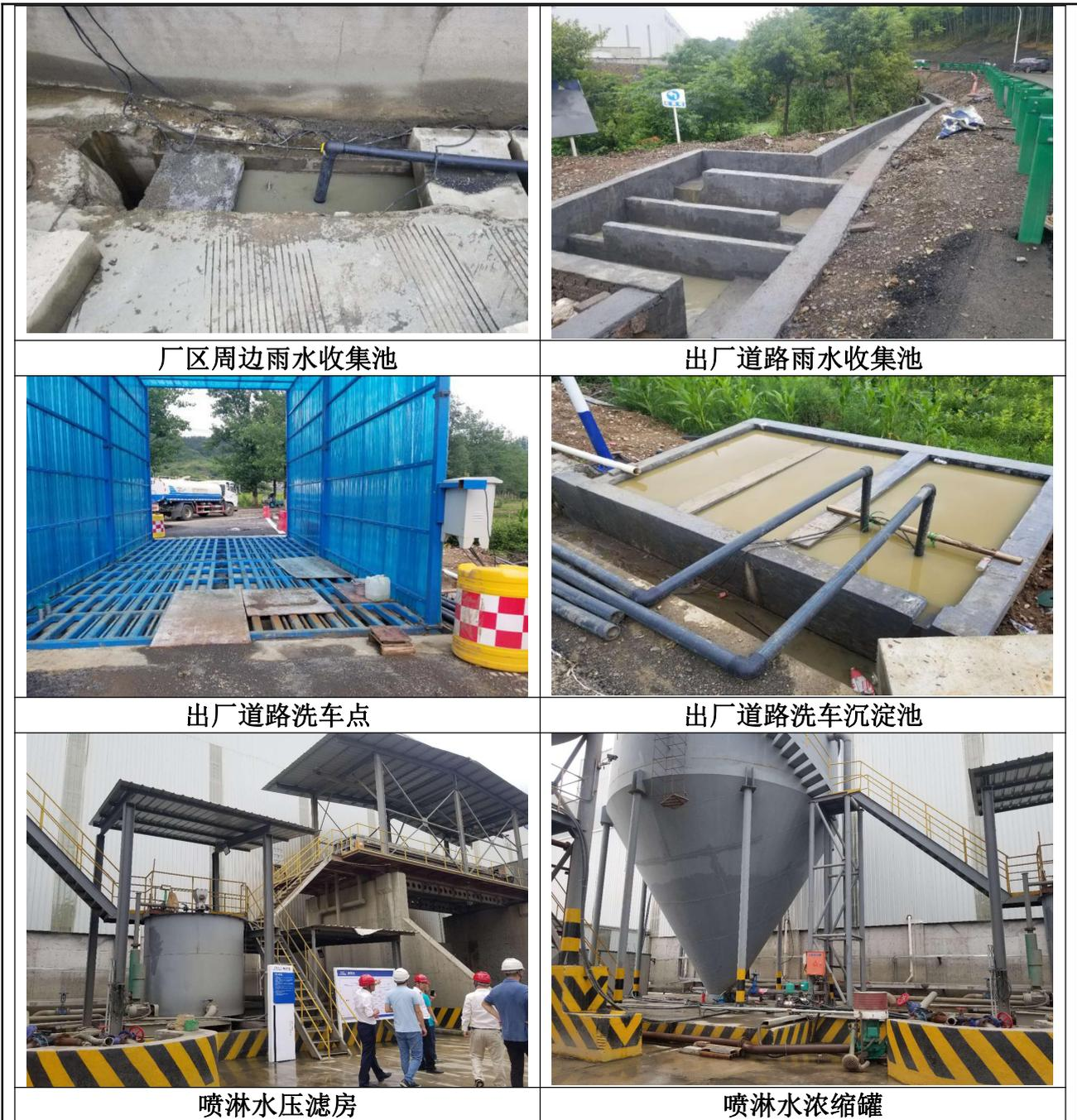
图 4-9 沉淀池、雨水沟、雨水池和喷淋水处理系统现场图
